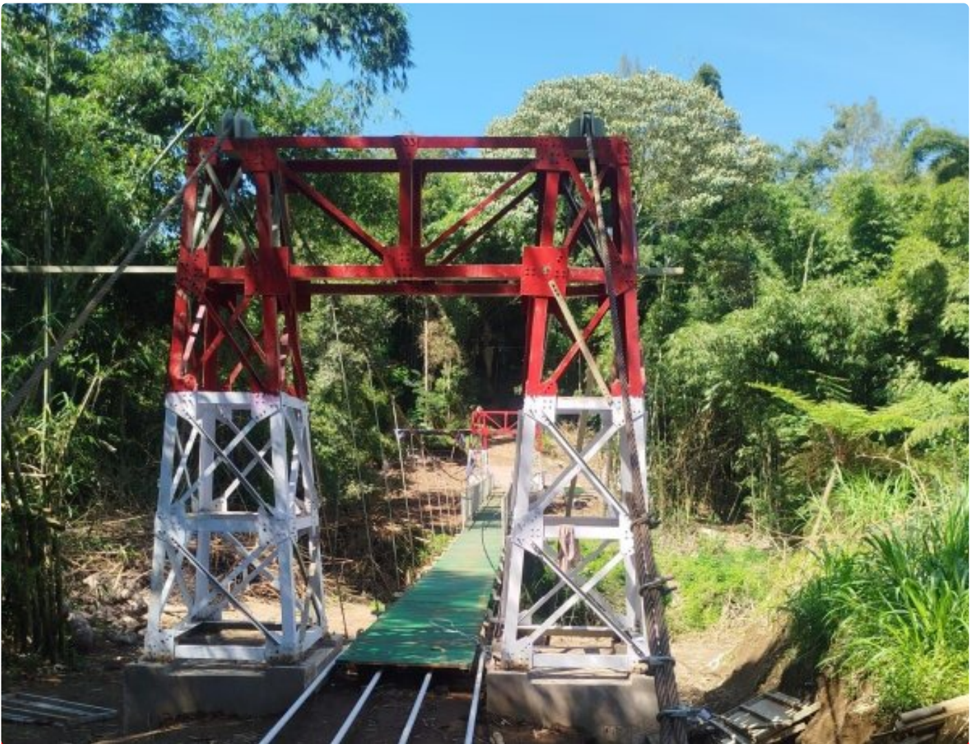
(Foto Dokumen) : Pembangunan jembatan perintis Garuda mencapai 100%
