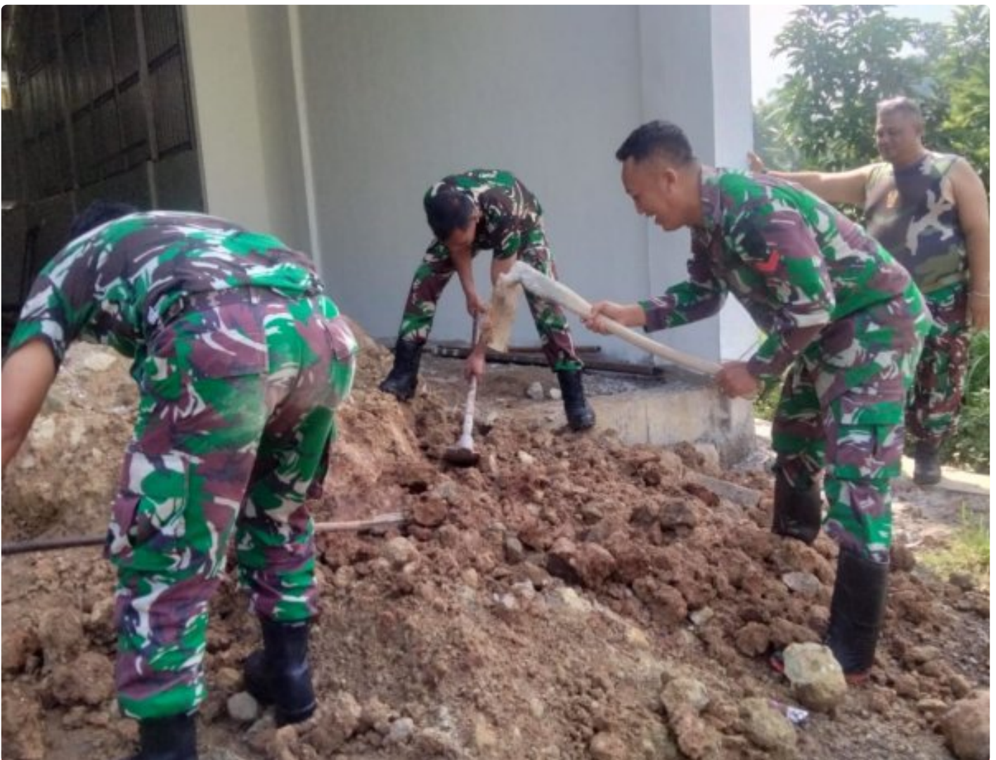
(Foto Dokumen) : Pembangunan KDKMP Desa Seloboro Kecamatan Salam
