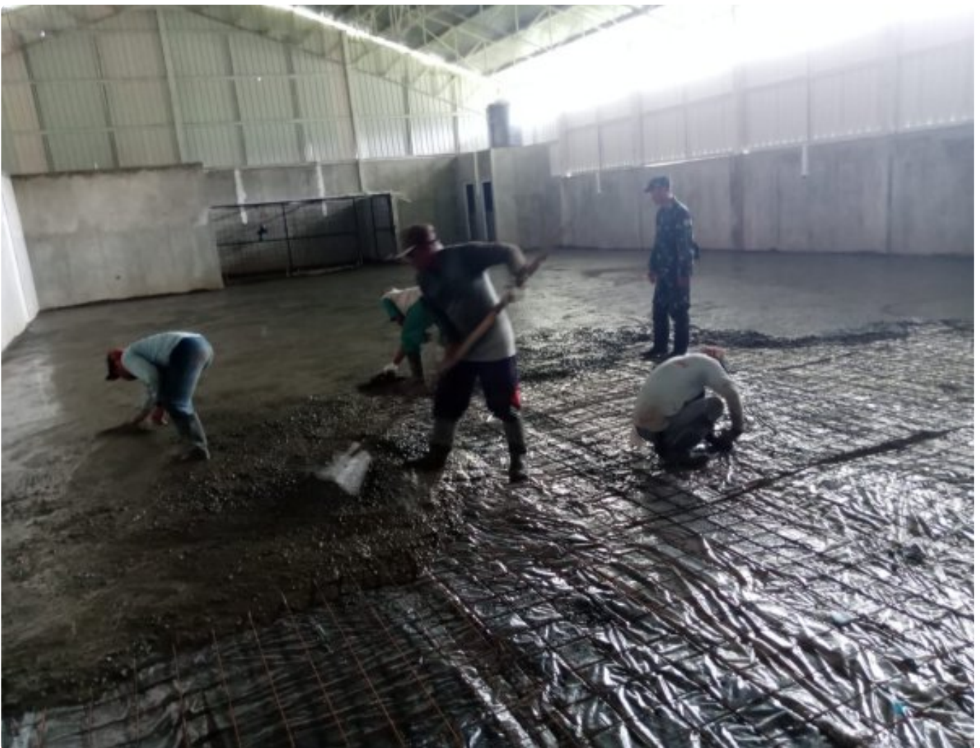
(Foto Dokumen) : Babinsa memantau pengecoran KDKMP
